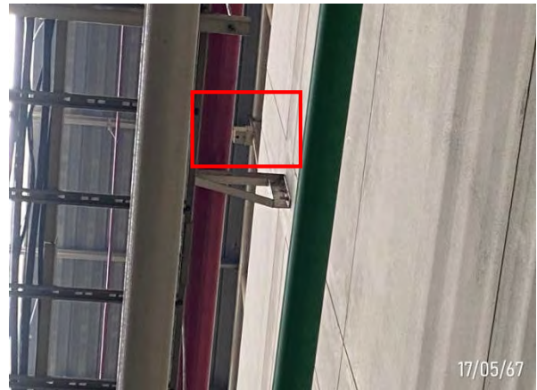
ชุดตรวจจับควันด้วยลำแสงปี่ม (Beam Smoke Detector)
