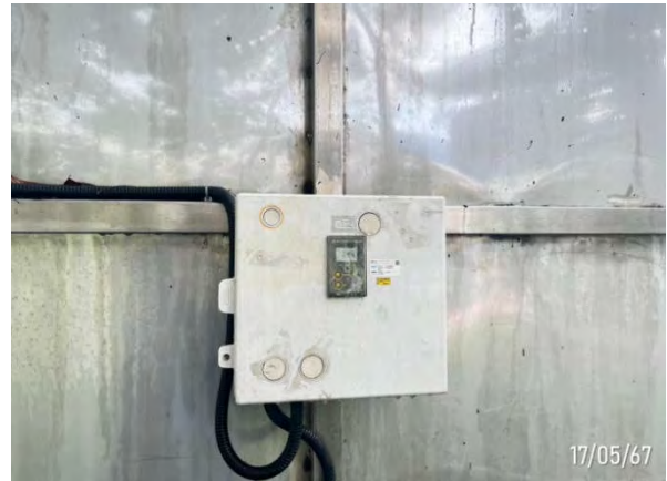
รูปที่ 3-13 เครื่องมือตรวจวัดค่า pH แบบอัตโนมัติ
