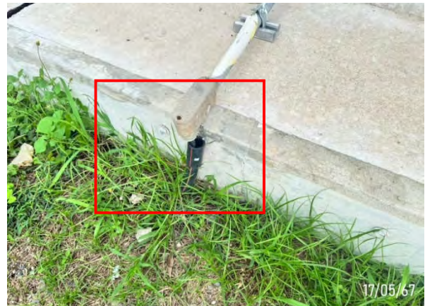
รูปที่ 3-50 การติดตั้งสายดิน
