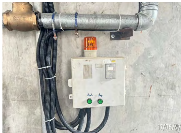
รูปที่ 3-14 เครื่องมือตรวจวัดค่า Conductivity แบบอัตโนมัติ
